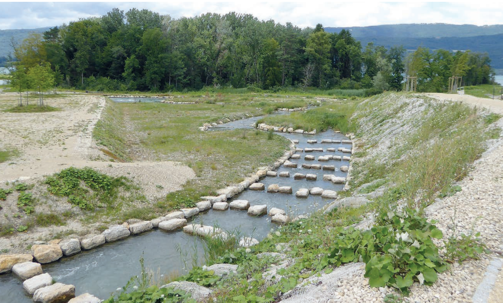
Umgehungsgerinne als Raugerinnebeckenpass Ruisseau de contournement en forme d'un passe à bassins rugueux
